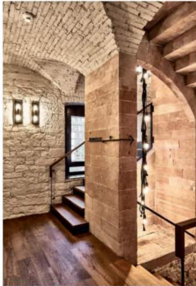
Von der Lobby führt der Weg hinab zum rustikalen Weinkeller. Das Gewölbe wurde von Putz und Farben befreit und anschließend behandelt. Die ursprüngliche Steinkonstruktion ist nun sichtbar
