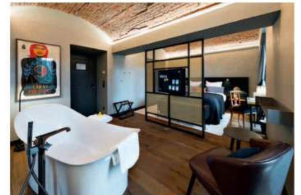
Für die Zimmer und Suiten wurden jeweils zwei bis drei alte Zellen miteinander verbunden und das Mehrfachgewölbe freigelegt, wie etwa im „Executive Room“
